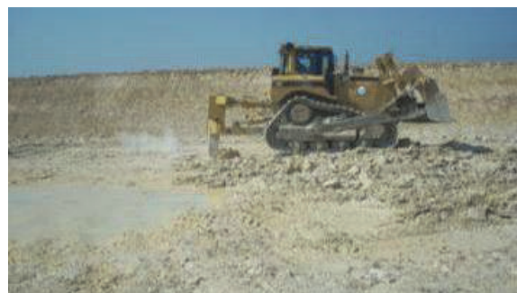
Figure 11. Destruction de la roche dans le fond du bassin
