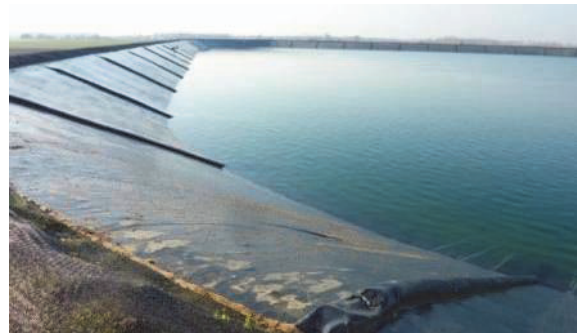
Figure 38. Système de lestage contre le vent
