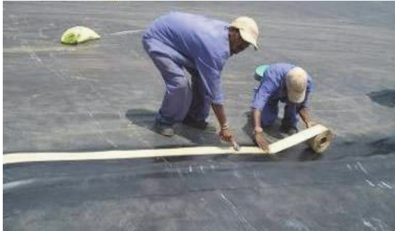
Figure 33. Assemblage de la géomembrane
