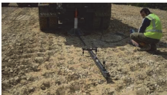
Figure 18. Contrôle du niveau de compactage
