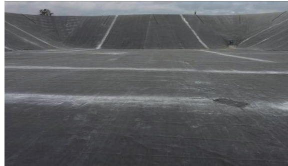
Figure 34. Vue sur le bassin après installation
