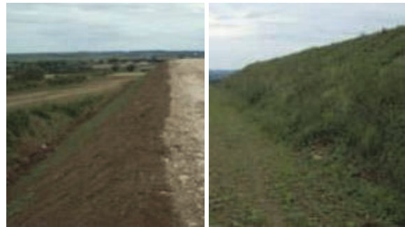
Figure 23. Talus extérieur avant et après végétalisation
