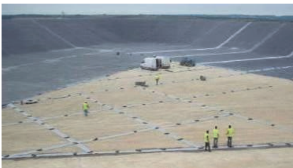
Figure 28. Drainage des gaz avec un géocomposite
