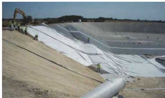
Figure 30. Installation du géotextile
