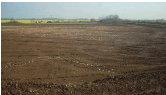
Figure 10. Le site au début des travaux
