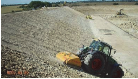
Figure 20. Broyage des éléments agressifs
