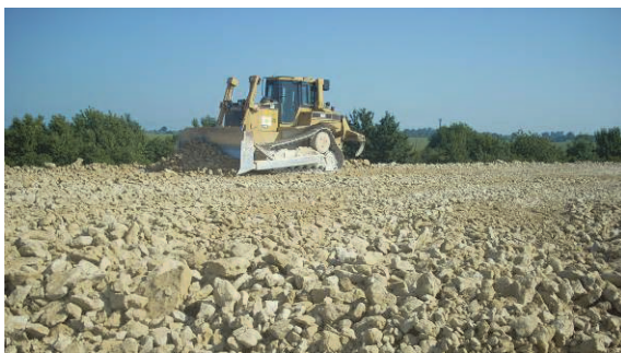
Figure 16. Régalage au bulldozer en tête de talus
