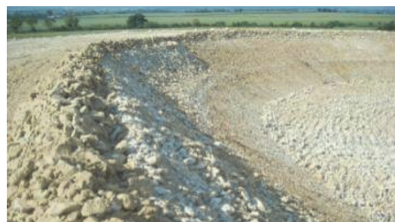
Figure 19. Vue des talus avant finition
