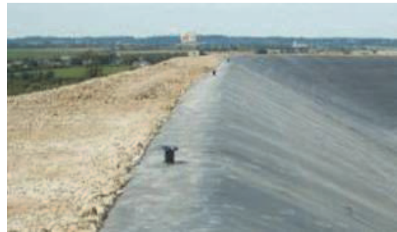
Figure 36. Tranchée d'ancrage après compactage
