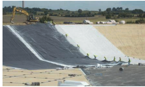
Figure 32. Dépliage de la géomembrane
