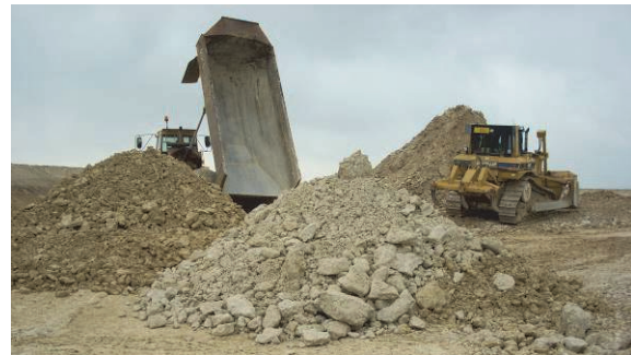
Figure 15. Remblais de la digue
