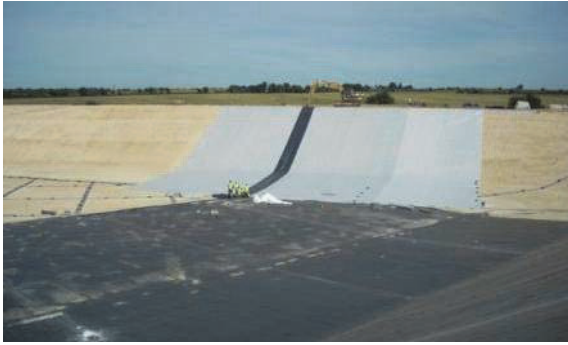
Figure 31. Déroulement de la géomembrane
