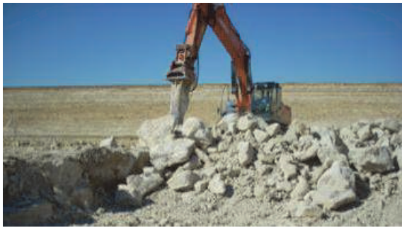
Figure 12. Concassage au marteau hydraulique
